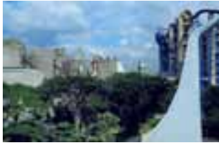
Kompleks Pabrik Citeureup, Bogor, Jawa Barat Pabrik ke (1-8) & 11 Citeureup Factory, Bogor, West Java Plants (1-8) & 11
